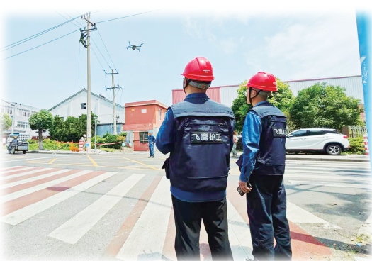
国网嘉兴供电公司员工在嘉善县10千伏金秀线网架标准化改造现场操作无人机开展无感化安全督查。李前营/摄
