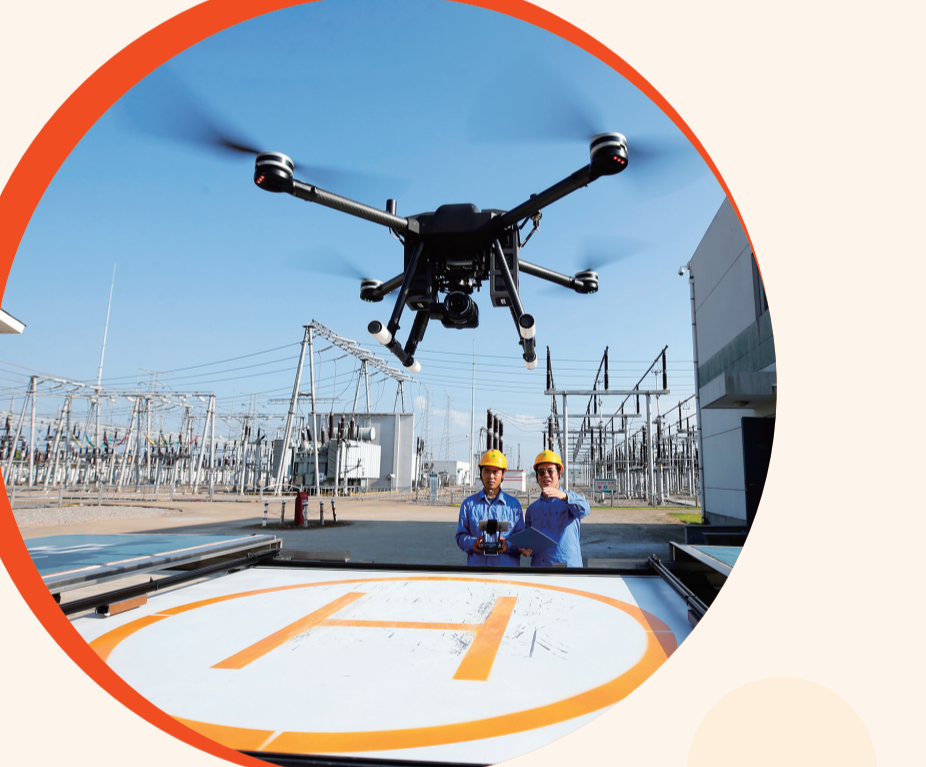
▲国网宁波供电公司输电人员通过升级航线设定，开展无人机自主巡视。 王鞠奕/摄
