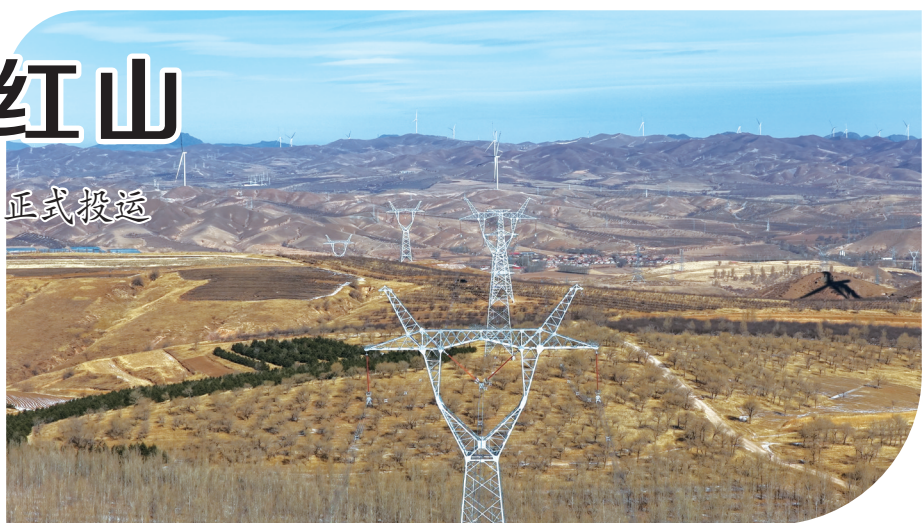
图为500千伏唐紫线浑善达克沙地100万千瓦送出线路。国网赤峰供电公司/供图
