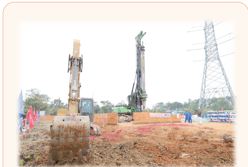
1月20日,藏粤直流工程广东段线路开工建设。李品/摄
