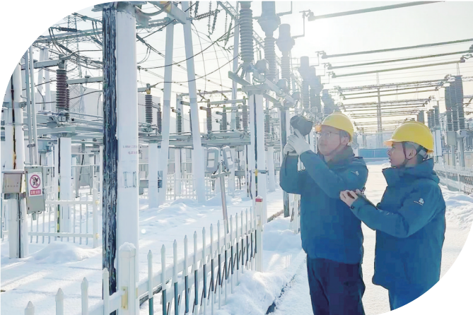
图为国网乌鲁木齐供电公司员工在220千伏三官变电站开展特巡测温。孔紫薇/摄
