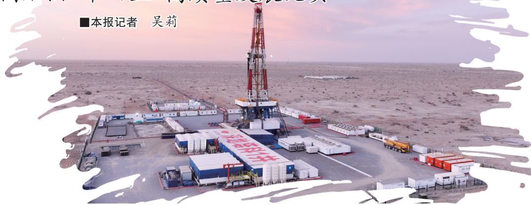
图为我国首口万米科探井——中国石油深地塔科1井。 中国石油/供图
