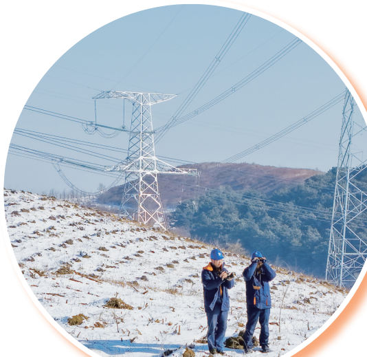
国网辽宁铁岭供电公司输电运行工区工作人员对500千伏泉岭1号线进行雪后巡检。 樊昊/摄
