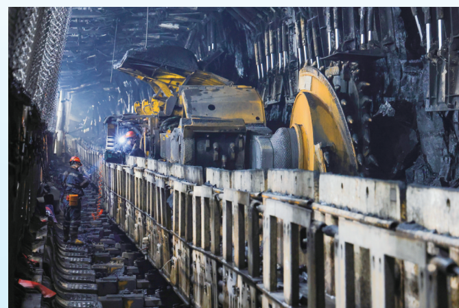
图为神东煤炭大柳塔煤矿大采高工作面检修。
