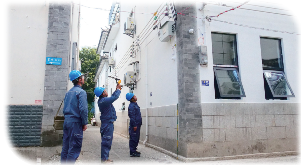
保供电工作人员对大理辖区内低电压设备开展测温工作，确保设备正常运行。
