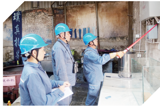
用电负荷高峰期，保供电人员主动上门服务，对喜洲镇周城村扎染博物馆开展用户侧配电箱安全检查。沙子键/摄
