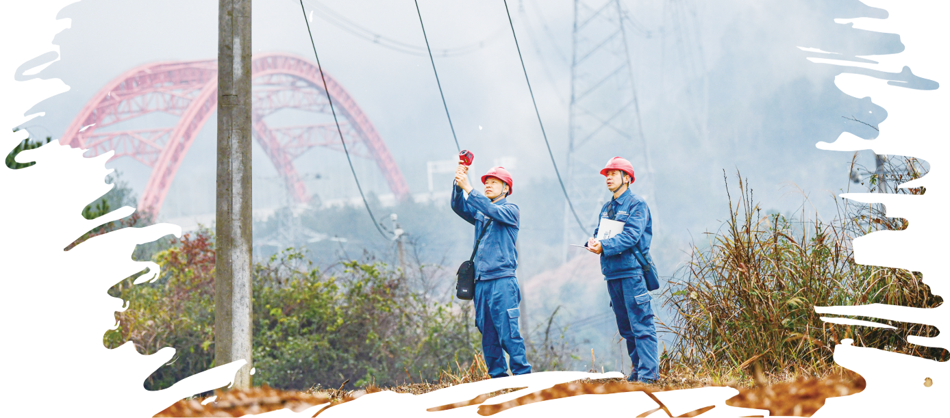
南方电网贵州电网公司凯里施秉供电局员工对10千伏七城I回配电线路开展巡视测温检查,及时消除设备安全隐患,全力保障电力供应安全可靠。 龙晓东/摄
