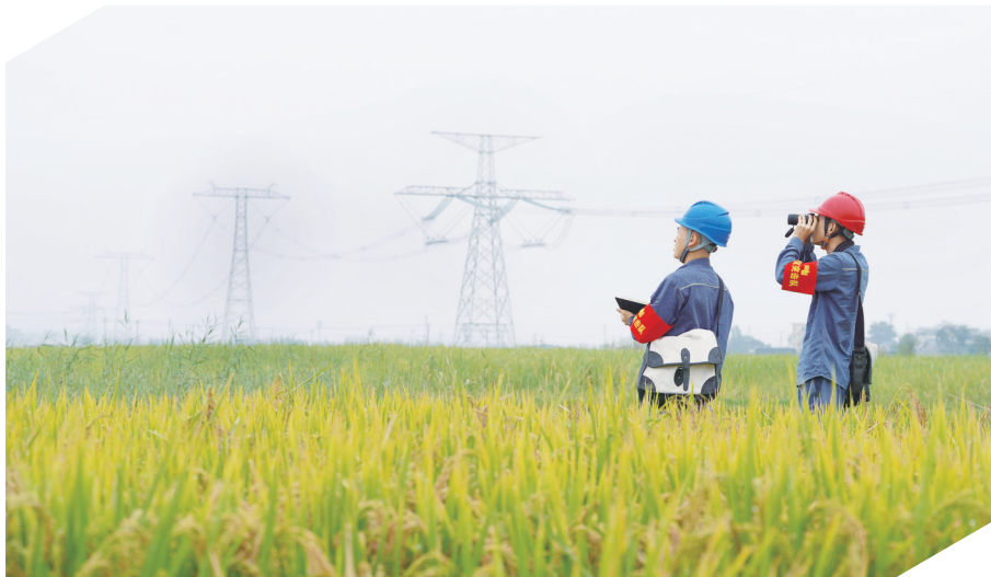
图为南网超高压公司曲靖局输电运维人员开展所辖±800千伏昆柳段直流358—370号塔区段交叉跨越点特巡。
