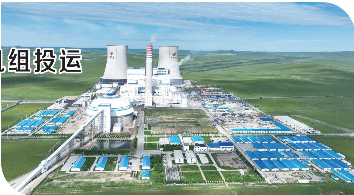
图为乌拉盖2×1000兆瓦高效超临界燃煤发电机组。
