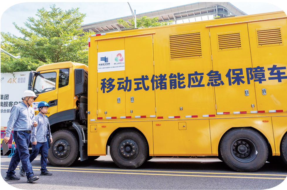
图为深圳供电局出动移动储能车保障火炬传递。黄志伟/摄
