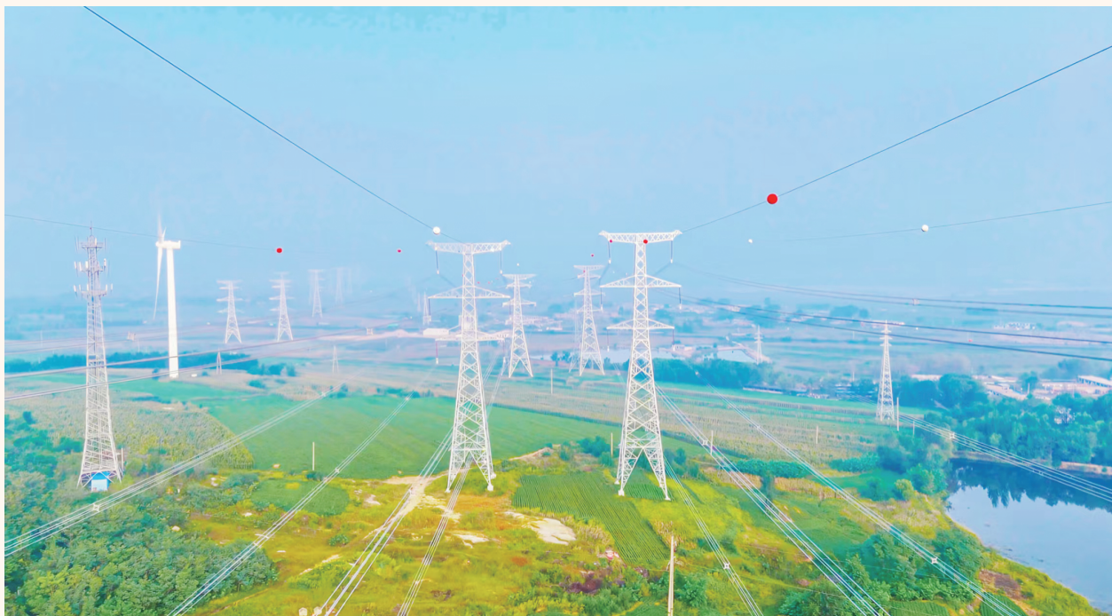
图为辽宁省葫芦岛市徐大堡500千伏核电送出工程。姜岩/摄
