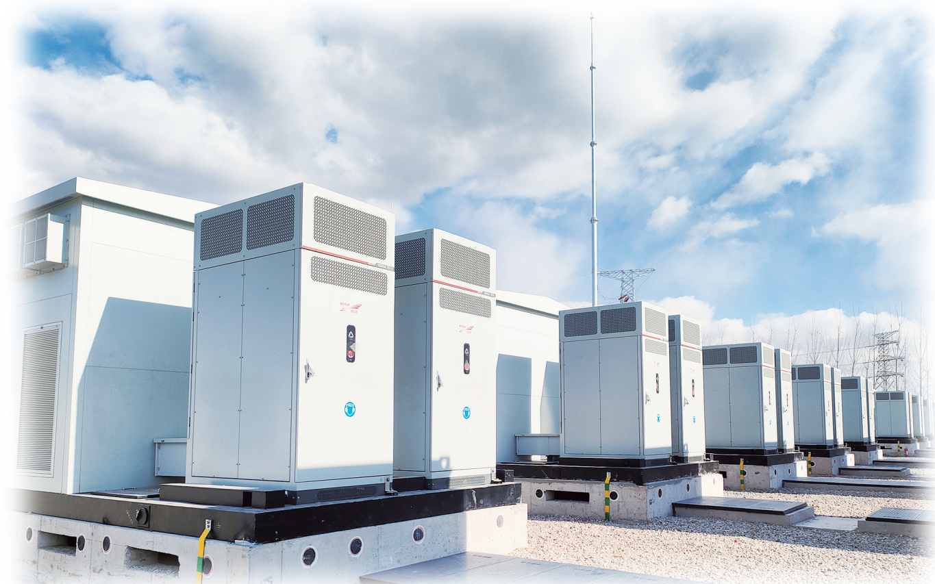
图为由科华数能提供储能解决方案的山东潍坊高密100MW200MWh集中式共享储能项目。科华数能/供图
