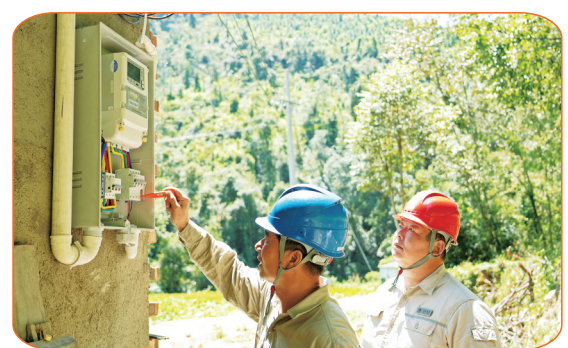
国网连城供电公司员工为邱金堂老人新房安装电能表。
