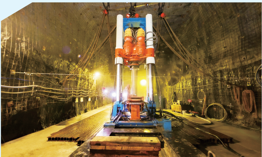
图为6.6米大直径反井钻通风孔施工现场
