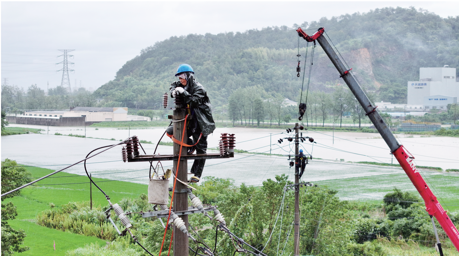
7月30日,受台风影响,浙江宁波海曙区高桥镇一企业铁皮厂房倒塌,压断10千伏蛟湖线一段导线,宁波供电公司抢修人员上杆抢修。 柴铮/摄
