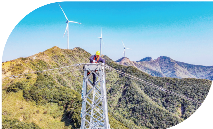
图为重庆丰都供电公司员工在回山坪风电场检修110千伏送出线路。罗一灵/摄
