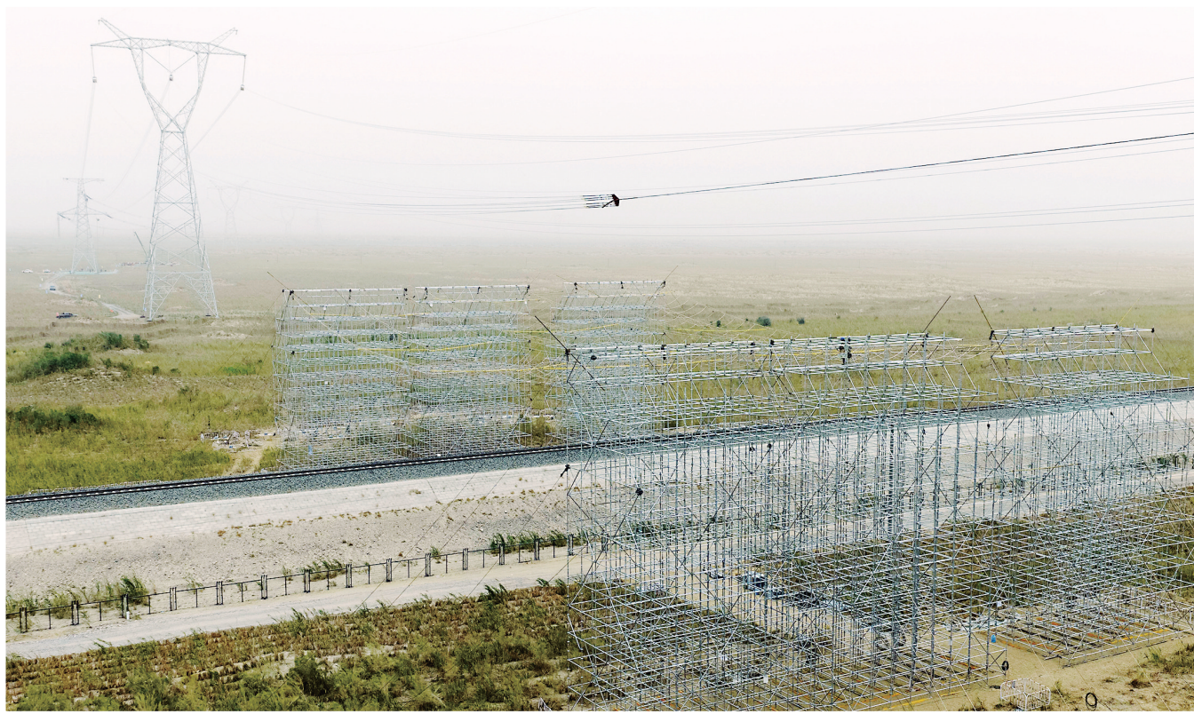
图为7月12日,民丰—且末—若羌750千伏输变电工程开展导线架设作业。马元/摄
