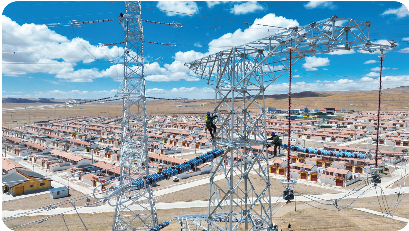
图为国网青海省电力公司施工人员开展330千伏玉树第二回线路工程消缺工作。张朋/摄
