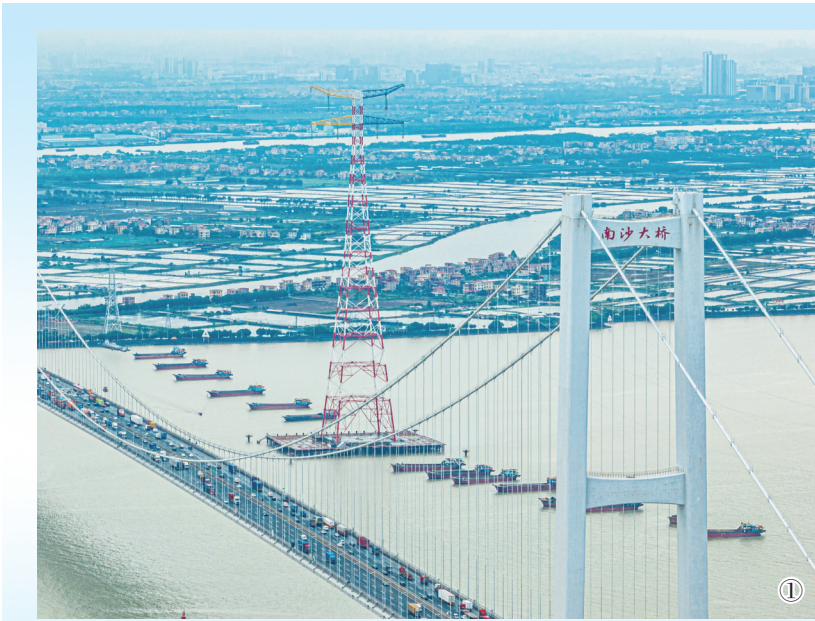
①从广州到东莞,布满狮子洋水道的17艘架线施工船正严阵以待。 陈海东/摄 ②狮子洋大跨越段架线施工中,作业人员正在空中吊笼压接导线。 陈晓全/摄 ③高空作业人员正在进行狮子洋大跨越塔的附件安装施工。 吴彦伟/摄
