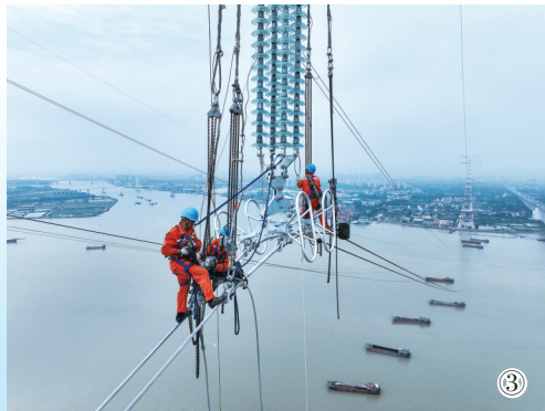
①从广州到东莞,布满狮子洋水道的17艘架线施工船正严阵以待。 陈海东/摄 ②狮子洋大跨越段架线施工中,作业人员正在空中吊笼压接导线。 陈晓全/摄 ③高空作业人员正在进行狮子洋大跨越塔的附件安装施工。 吴彦伟/摄
