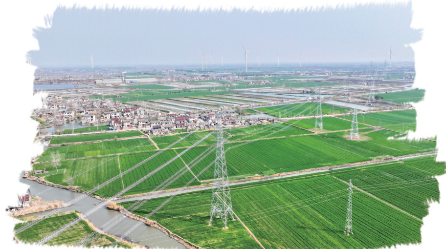
图为扬州—镇江±200千伏直流输电工程输电线路。
