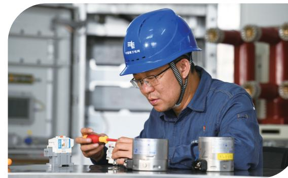
从2019年开始,他便带领团队踏上技术攻关之路。经过反复多次装拆试验,他们终于掌握了断路器操作机构的各构件功能及工作原理,断路器操作机构的技术壁垒也被彻底打破。
