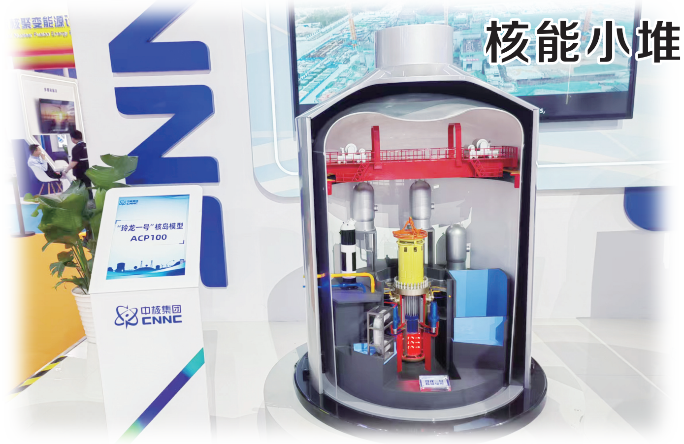
图为第十六届中国国际核电展上的全球首个陆上商用模块化小堆——“玲龙一号”反应堆模型。朱学蕊/摄
