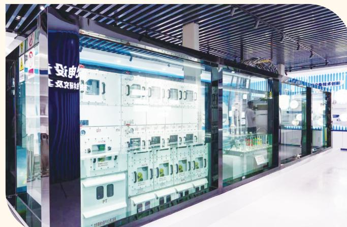
浸于水池中的南方电网首套防水浸中低压配电设备。黄志伟/摄
