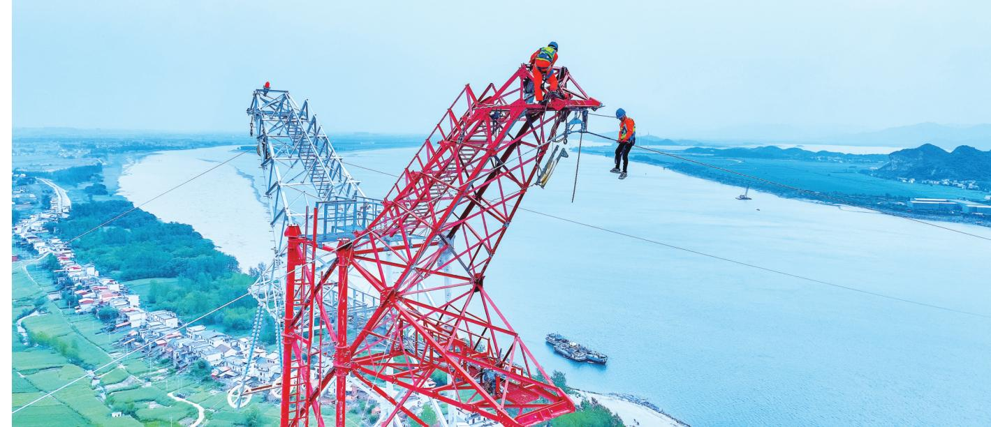
4月16日至20日，江西省重点工程、江西“十四五”碳减排示范项目——彭泽县棉船风电项目110千伏配套线路进入跨长江放线作业，配套线路全长22.92公里，其中长江大跨越段长约2.7公里，主跨距离1.6公里。该项目投运并入电网后，可满足30万户家庭用电需求，同时可为棉船镇7000多名常住居民提供高质量用电，助力打造“零碳岛”，共同推进长江经济带绿色发展。
