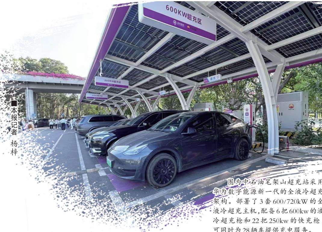
图为中石油架山超充站采用华为数字能源新一代的全液冷超充架构。部署了3套600/720kW的全液冷超充主机,配备6把600kw的液冷超充枪和22把250kw的快充枪,可同时为28辆车提供充电服务。
