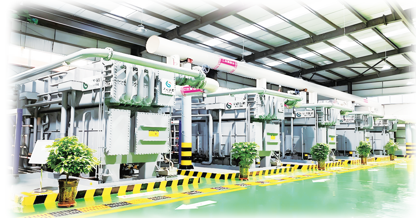
图为银川长输供暖工程吸收式热泵机组。华源泰盟/供图
