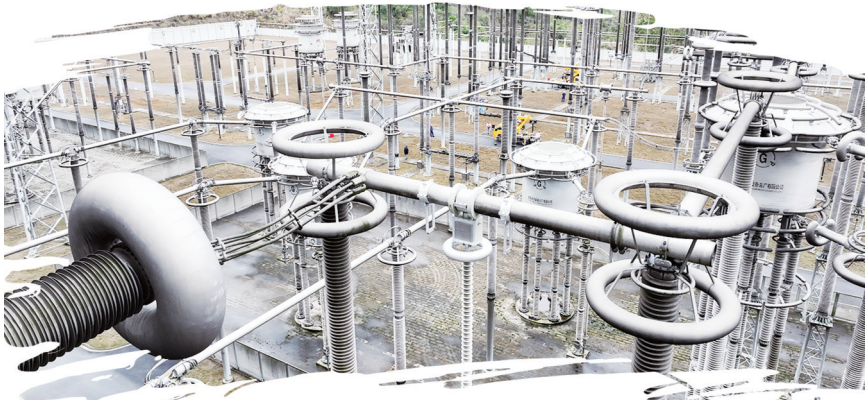
图为量子电流传感器高压侧装置安装点,位于800kV直流穿墙套管与桥臂电抗器连接的管母处。南方电网/供图
