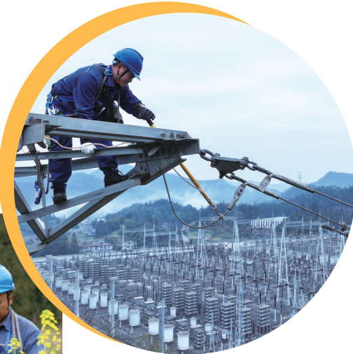
▲ 图为3月23日,南方电网超高压公司曲靖局检修人员装设牛从直流乙线1号塔地线永久接地线。 戴永平/摄
