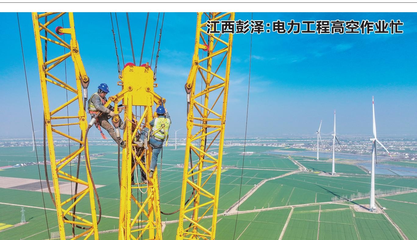
3月18日,在江西彭泽县棉船风电场外送电力线路工程现场,江西送变电公司施工人员正在实施吊塔高空作业。棉船风电项目是江西省重点建设项目和碳减排示范项目,作为配套外送电力线路工程的高杆塔建设已完成97%,将打通棉船风电集群并网外送“最后一公里”。
