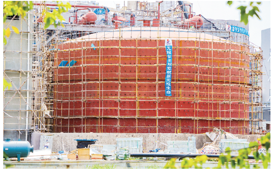
高、低温熔盐罐系统 严璐瑶/摄
