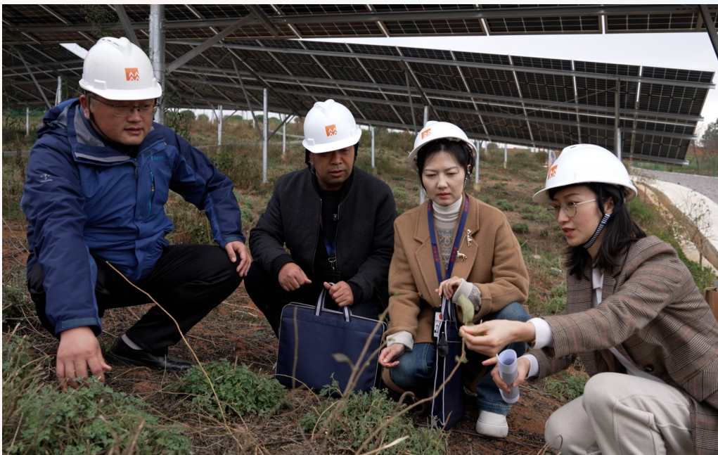
昆明市发展改革委先锋服务队党员深入昆明市宜良县华润“药光互补”项目现场,实地了解项目建设进展,现场协调解决困难问题,以党建引领助推项目建设提速增效。
