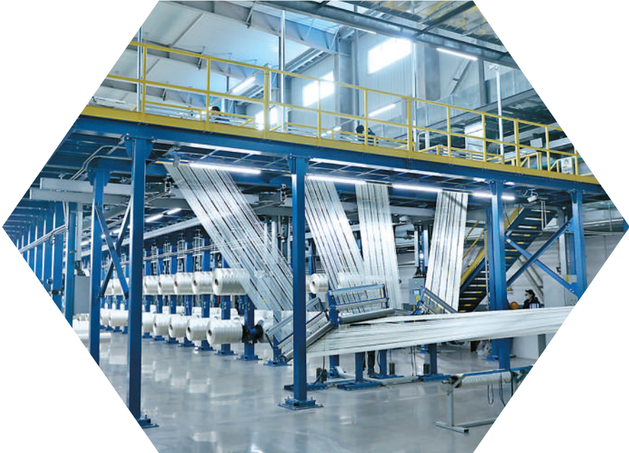
▲吉林化纤集团碳纤维生产车间。
