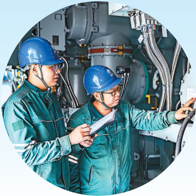
在东树220千伏变电站建设现场，国网邢台供电公司员工检查设备安装情况。 韩旭摄
