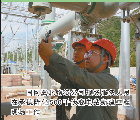
国网冀北物资公司专员在检查气体绝缘组合电器设备产品质量
