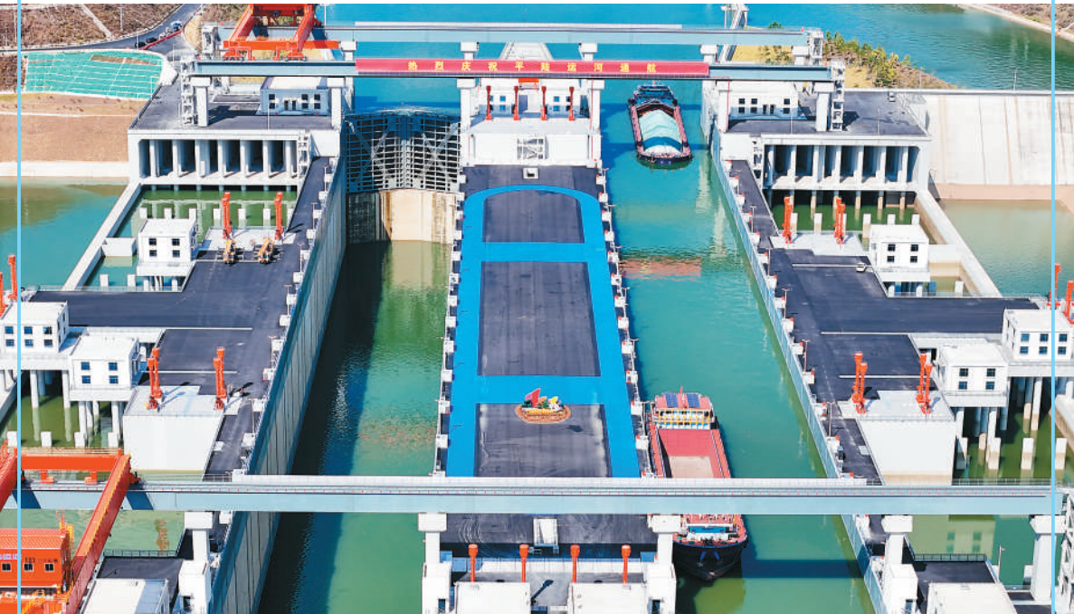
近日，两艘货轮在位于广西壮族自治区钦州市灵山县旧州镇的平陆运河马道枢纽等待过闸。
