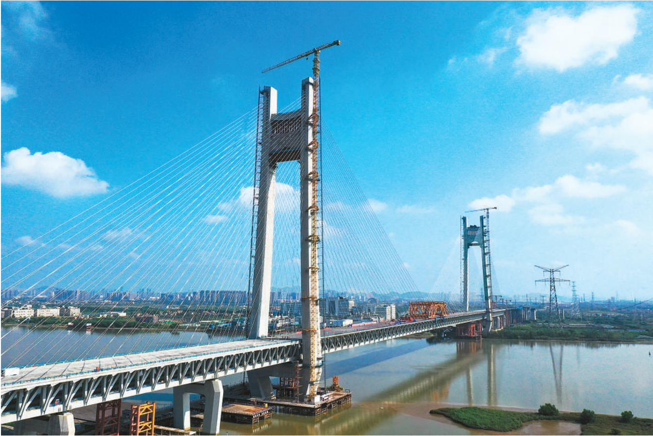
粤港澳大湾区最大跨度的公路高铁两用大桥——深江铁路洪奇沥水道公铁大桥近日成功合龙。深江铁路是我国“八纵八横”高铁网沿海通道的重要组成部分，洪奇沥水道公铁大桥是深江铁路关键性控制工程之一。图为深江铁路洪奇沥水道公铁大桥合龙现场。
