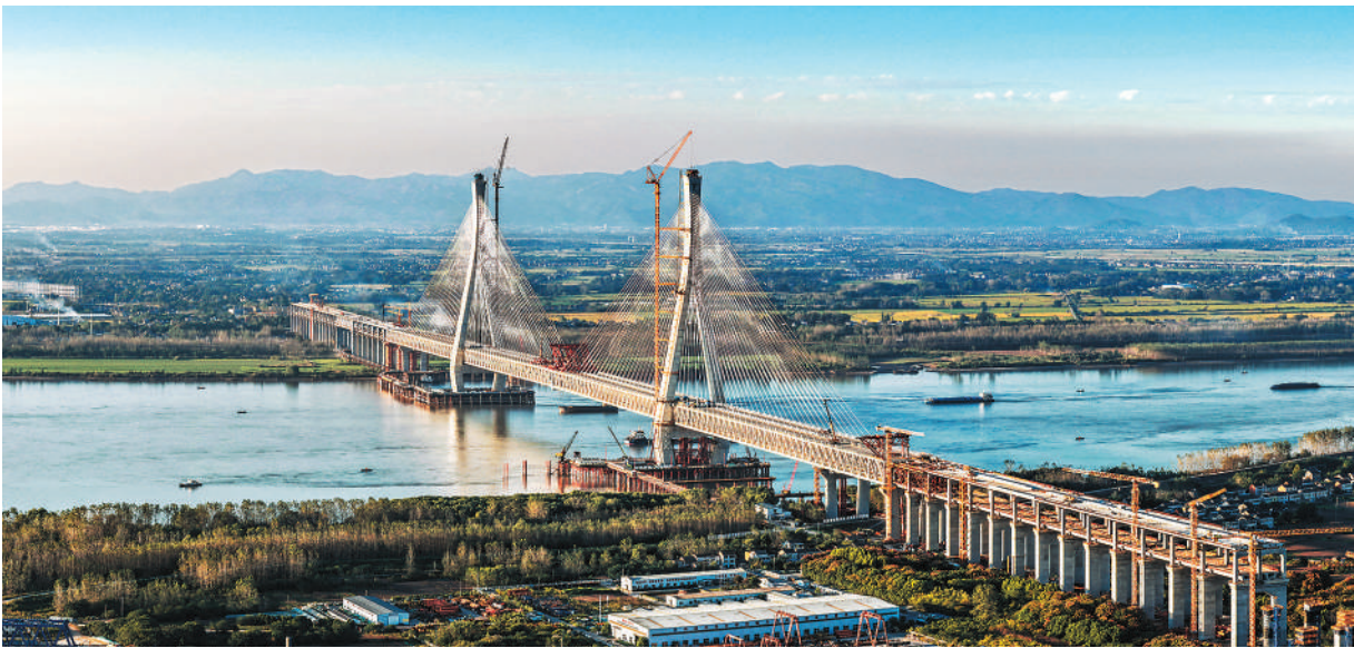
10月15日,池州长江公铁大桥主桥顺利合龙,主体工程基本完成,后续将转入附属工程和桥面铺装施工阶段。池州长江公铁大桥连接安徽省池州市贵池区和铜陵市枞阳县,线路全长3108.5米,其中跨江主桥长1768米,由中交二航局等单位施工。建成通车后,对深化区域互联互通、助力长三角一体化高质量发展等具有重要意义。 图为大桥建设现场。 康朴、谢啸天摄影报道
