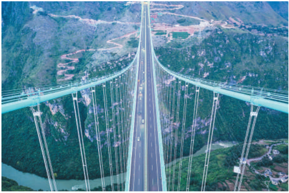
贵州花江峡谷大桥。新华社记者杨文斌摄
