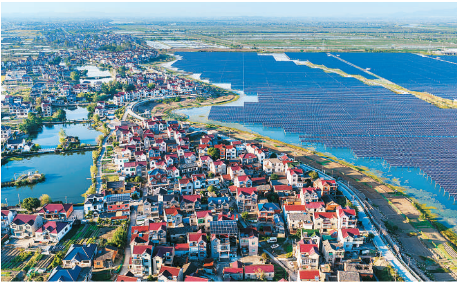
安徽省马鞍山市当涂县大陇镇依托江南水乡优势,将光伏产业与养殖业相结合,实现水上发电、水下养殖协同增效,提升土地(水域)综合利用率。 图为日前,大陇镇双潭湖“渔光互补”光伏电站与田园村居相映成景。 李成林摄(人民视觉)
