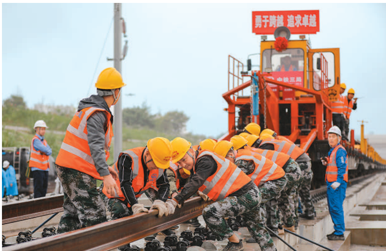
位于四川省南充市顺庆区的成达万高铁铺轨施工现场。 黎 涛摄（人民视觉）
