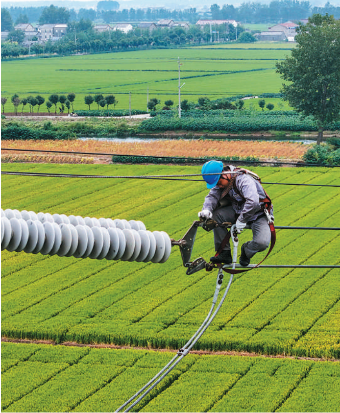
江苏省淮安市淮安区漕运镇，电力工人正在对线路实施秋检，及时消除安全隐患，为冬季电网安全运行护航。
