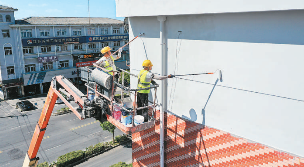
盐城市大丰区系统推进老旧小区改造。
