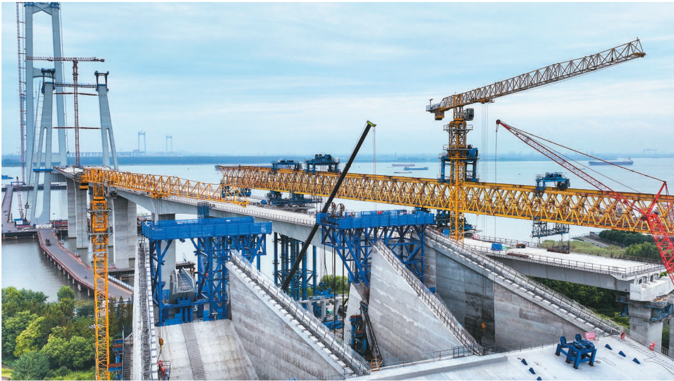
张靖皋长江大桥连通江苏省张家港、靖江、如皋三市，跨江段全长约7.9公里，建成通车后，将进一步优化长江干线过江通道布局，完善区域路网。图为位于张家港市的张靖皋长江大桥南锚碇施工现场，工人们操作设备将散索鞍精准吊装就位。 施柏荣摄（人民图片）
