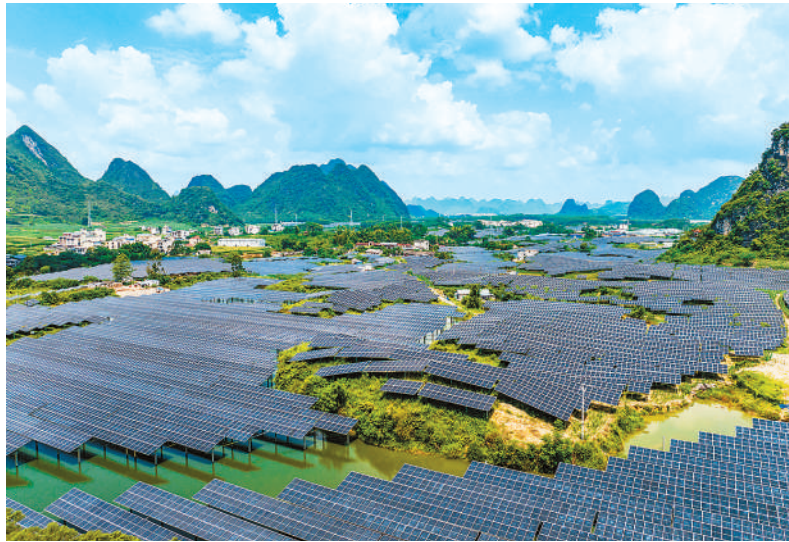
近年来，广西壮族自治区河池市大化瑶族自治县依托光照与荒坡资源优势，因地制宜发展绿色能源产业，探索“一次投资、循环发展、长期收益”的致富路径，让群众共享绿色能源发展红利，赋能乡村全面振兴。图为大化瑶族自治县红旗光伏发电基地连片的光伏板。
