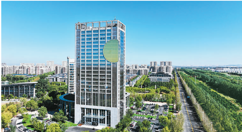
铁岭市日鑫大厦盘活后，成为智慧化办公大厦。
