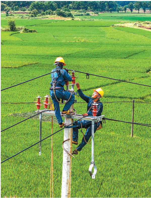
湖南省永州市新田县视头镇老夏荣村,电力工人正在进行电网改造作业。刘贵雄摄(人民视觉)
