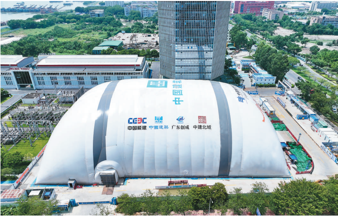
近日，由中建八局华南公司与广东电网有限责任公司广州供电局联合打造的“第三代基坑专用气承式气膜系统”在位于广州市南沙区的南沙供用电实操用房（二期）项目顺利投运。该系统以绿色智能施工技术破解城区深基坑建设多重痛点，打造粤港澳大湾区电力基建创新范例。图为建设完成的“第三代基坑专用气承式气膜系统”。 张鹏豪摄（人民视觉）
