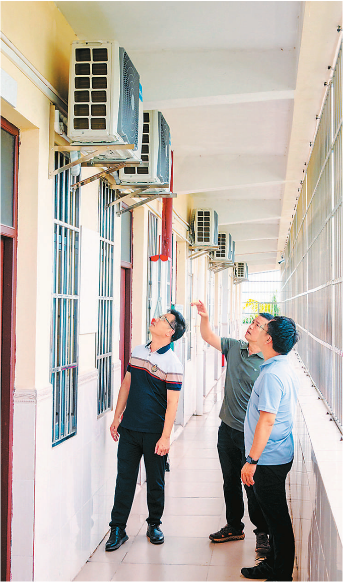
海口市永兴中学学生宿舍区，学校工作人员在查看安装好的空调。
