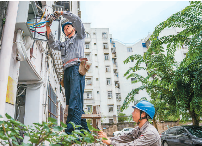
在海口市龙华区城西镇金盘路的一个老旧小区内，电力工人对小区电路进行改造。该小区改造完成后，将实现电力抄表到户。
